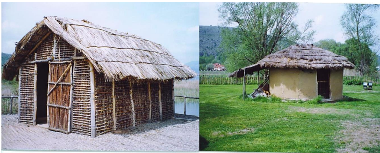
Πηγή εικόνας: Edu-Gate
